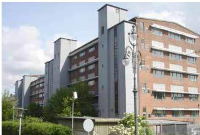
Ejendommen Tagensvej 135, set fra Superkilen. Center for Bydesign.
