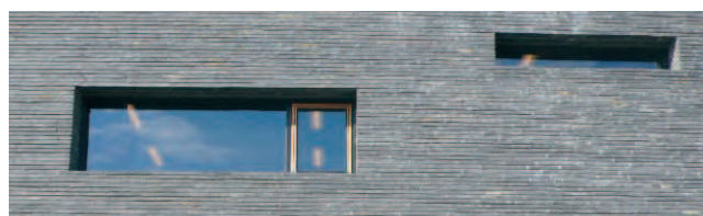
Eksempler på detaljering i murværk, som understreger en bygningens tyngde (Kilde: HLA)
