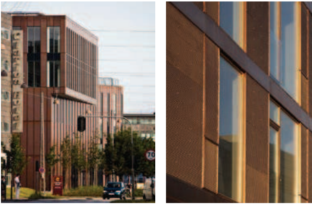
På disse to fotos ses et eksempel på et naturligt materiale i form af kobberfacade. 'Sydporten' i Sydhavnen, Henning Larsen Architects.
