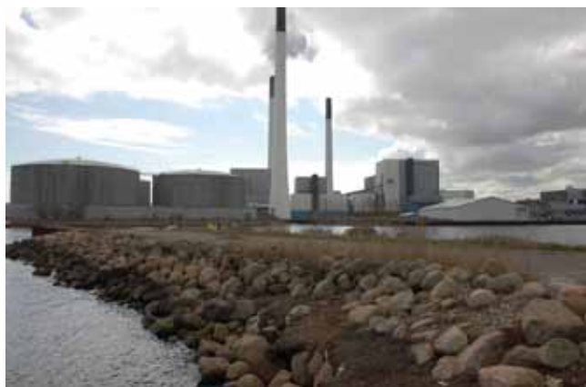
Amagerforbrænding samt Amagerværkets olietanke og skorstene set fra Refshaleøen.
