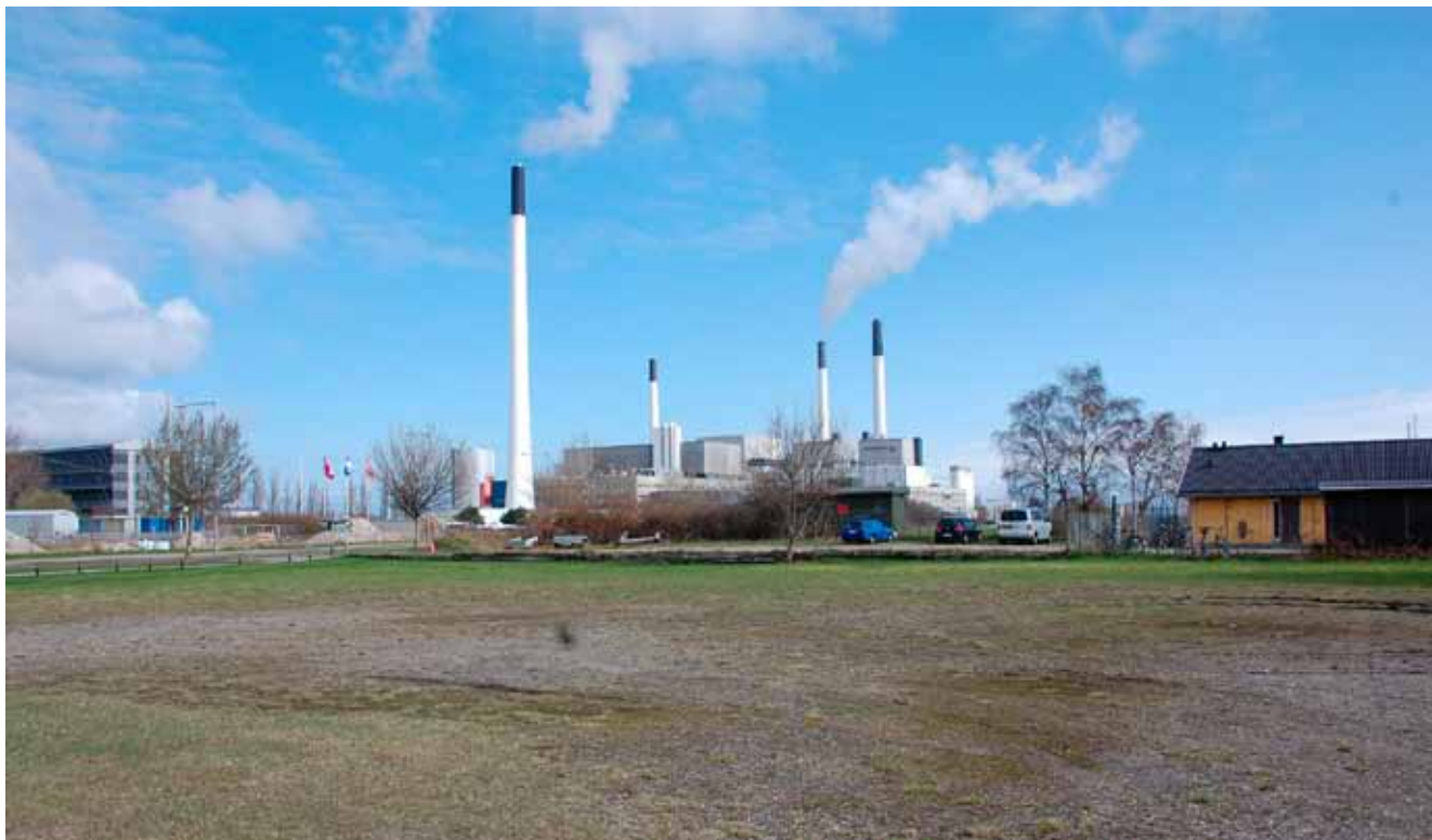
Amagerforbrænding og Amagerværket set fra et areal op til Københavns Motorbådsklub.
