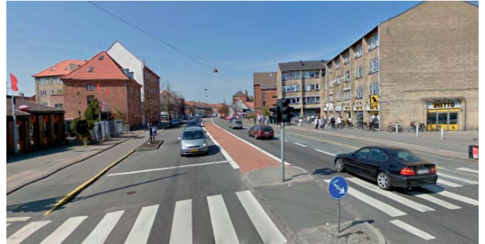
ill. 6: Nuværende situation ved Havdrupvej.
