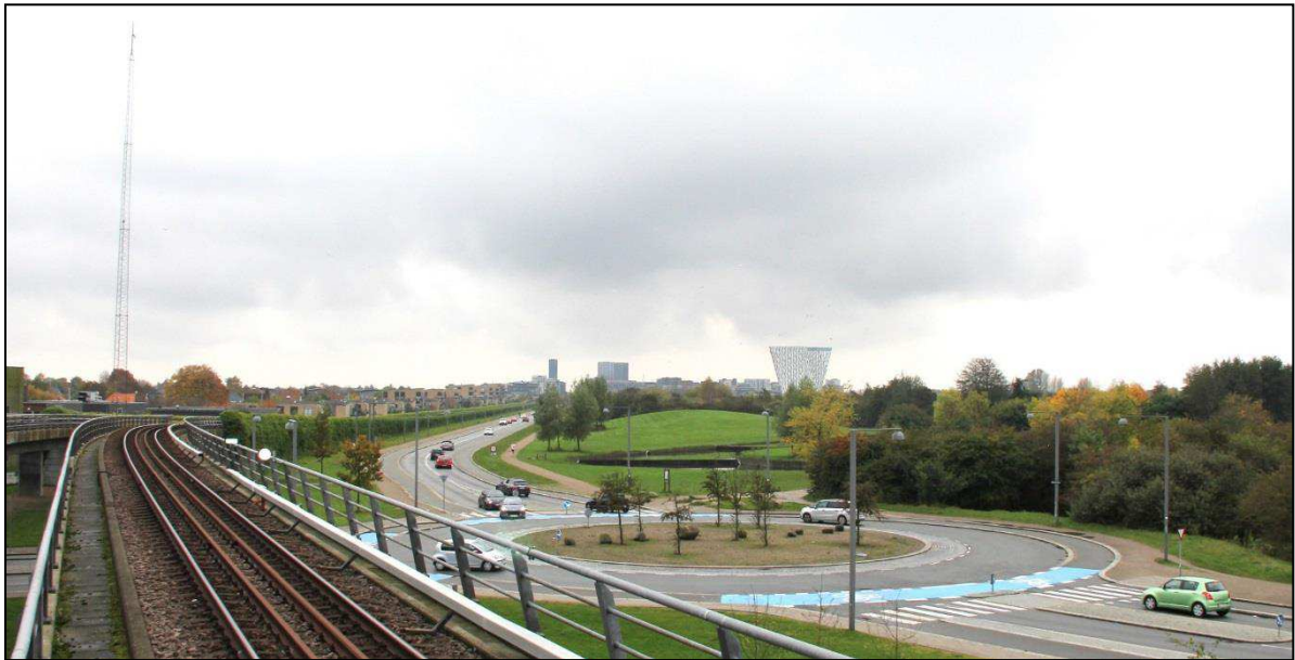
Figur 5-10. Eksisterende forhold ved perronen på DR Metrostation.
