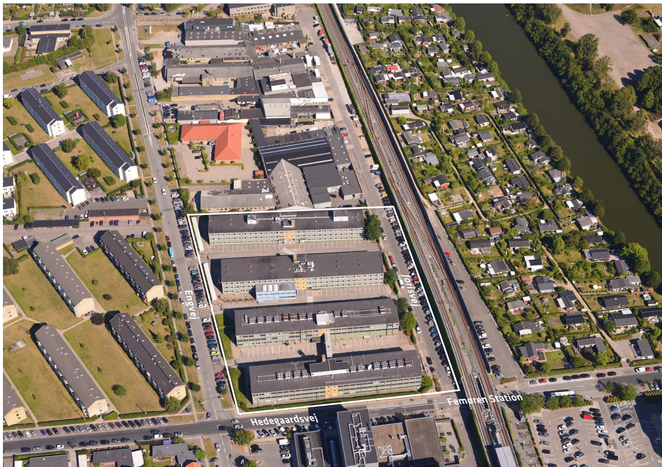
Lokalplanområdet ved Femøren Station med de fire erhvervsbygninger, der ønskes ombygget og udbygget til hotel og ungdomsboliger.
