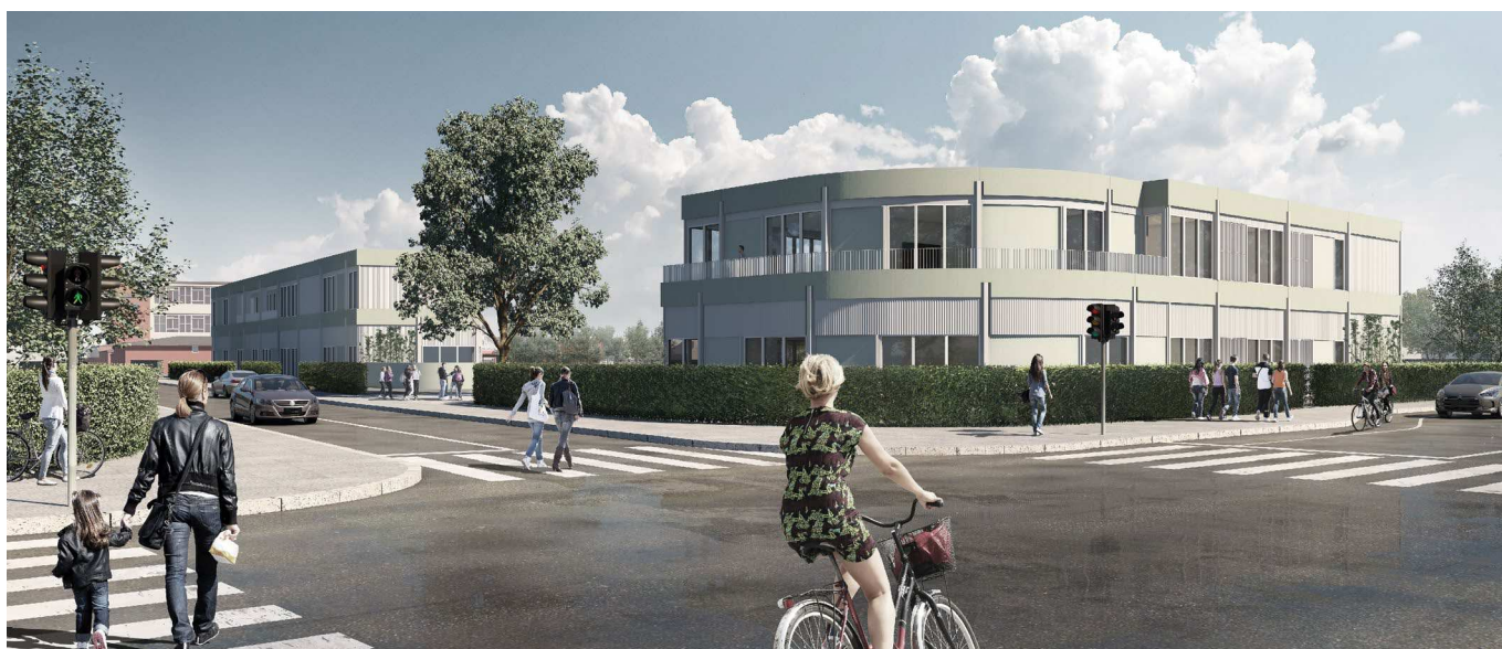
De to nye bygninger set fra krydset ved Backersvej og Samosvej (Illustration: Nøhr & Sigsgaard Arkitektfirma).
