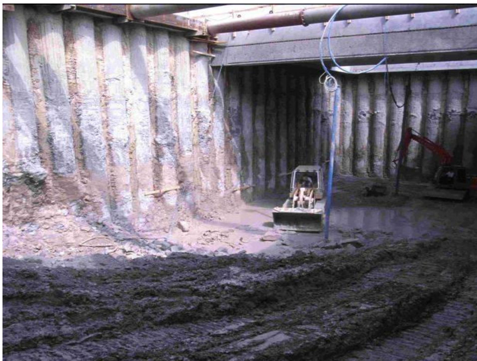
Figur 4-16 Udgravning af stationsboks mellem afstivende vægge udført med sekantpæle i armeret beton, Københavns Metro.
