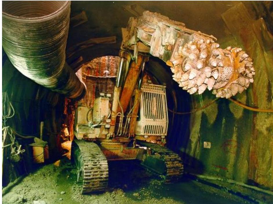
Figur 4-18 Fræsemaskine "roadheader" til udgravning i kalkundergrund, Københavns Metro
