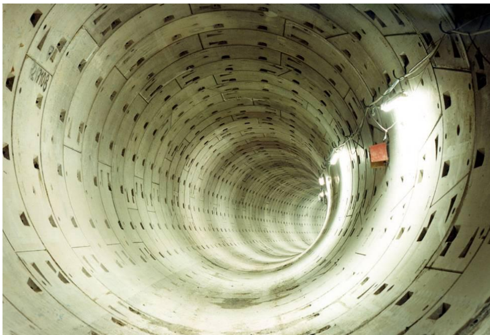
Figur 4-12 Tunnelrør beklædt med præfabrikerede betonelementer. Eksempel fra Københavns Metro.
