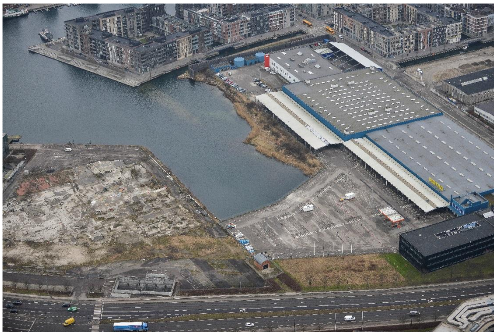
Figur 11-6 Oversigtsfoto over området ved den sydlige del af Teglholmen hvor stationen v/Sluseholmen vil blive placeret. 2015
