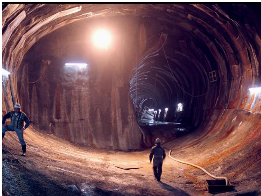
Figur 4-19 Kaverne udført med NATM-teknik og sprøjtebeton, Københavns Metro.
