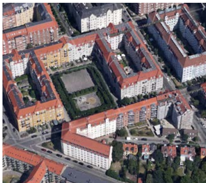
Fig. 6.1.1. Facadematerialer og sammensætningsprincipper på Amagerbro
