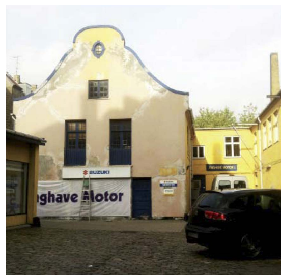
Hollænderhuset i gården, Enghavevej 16, (3) Privat bygherre
