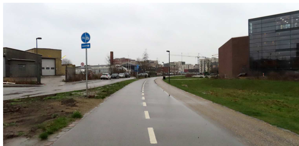
Med enkel greb kunne cyklister introduceres til den oprindelige bane mod syd Langs Amagerbanen. Også dette industriområde opstod i kraft af banen.
