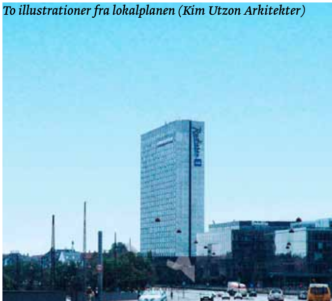
Eksisterende forhold set fra Langebro
