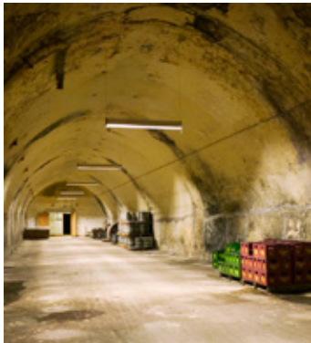
Kælderen under Rød Lagerbygning.
