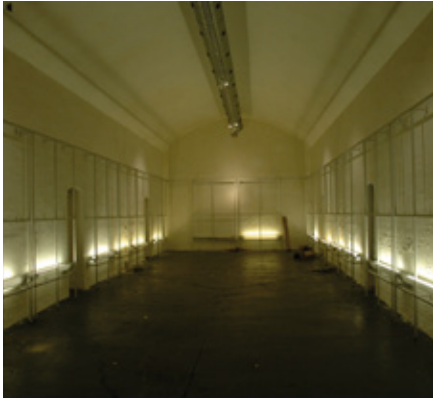
Den eksisterende kælder under pladsen
