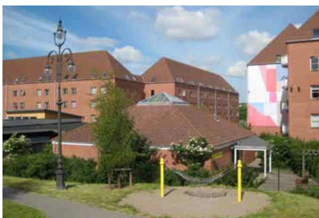
Mjølnerparken med beboerhuset i forgrunden, set fra Superkilen. Beboerhuset er en barriere for adgang mellem Superkilen og Mjølnerparken. Bebyggelsen er generelt karakteriseret ved rødt tegl og høje tagkonstruktioner. Byens Udvikling.
