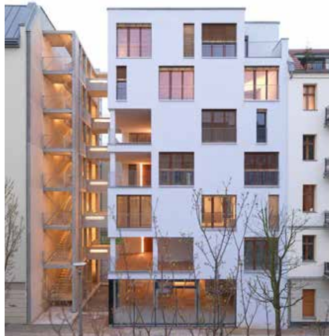
Eksempel på stueetage med en høj grad af transparens og varieret facadeudtryk. Reference fra Berlin. Foto: KHS Arkitekter.
