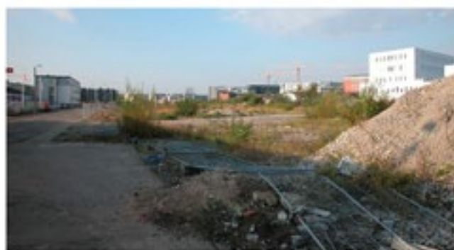
Området mellem Vestre - og Østre Teglsgade set fra Nordre Teglsholmen.
