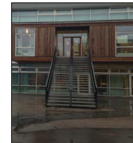
SKOLENS BYGNINGER ER I TO ETAGER OG DANNER OVERSKUELIGE RUM TIL FØRSKELLIGE FUNKTIONER
