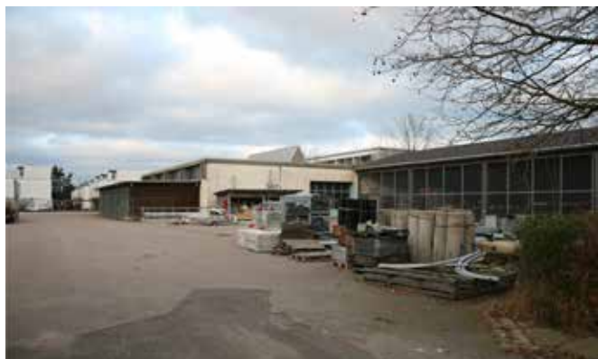
Eksisterende værkstedsbygninger på lokalplanområdet
