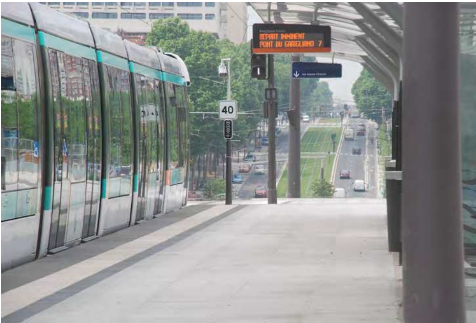
Paris. Letbanen fremstår på store dele af strækningen som et grønt tæppe, der mildner gadeprofilen og gør det langt mere behageligt både at opholde sig ved og cykle og gå langs med Boulevarden end det var tidligere.
