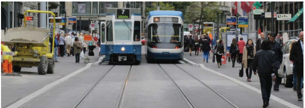
Eksempel på anvendelse af rilleskinner i Zürich, 2013.
