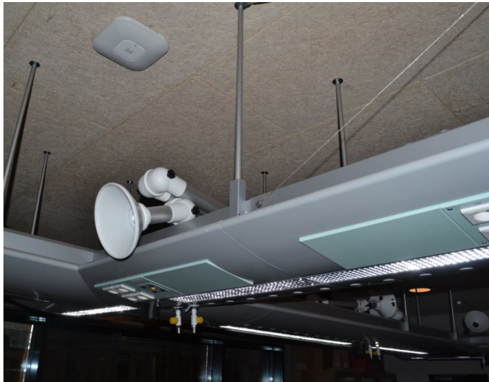
Eksempel på faglokale/laboratorie med installationer i loft der giver mulighed for fleksibel indretning, Nørrebro Park skole.
