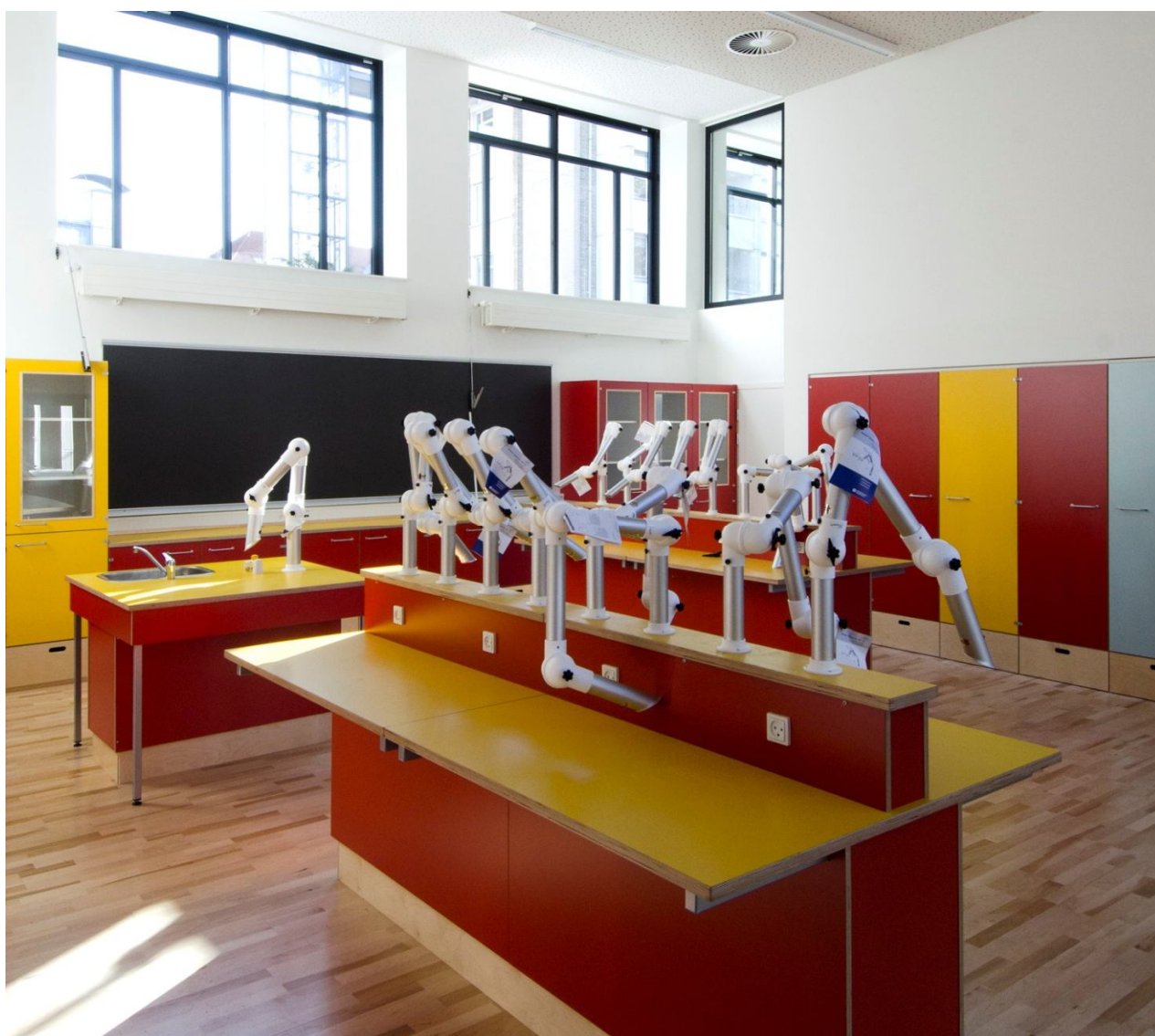
Eksempel på indretning af faglokale/laboratorie med faste "elev-øer" med installationer, Tagensbo skole.
