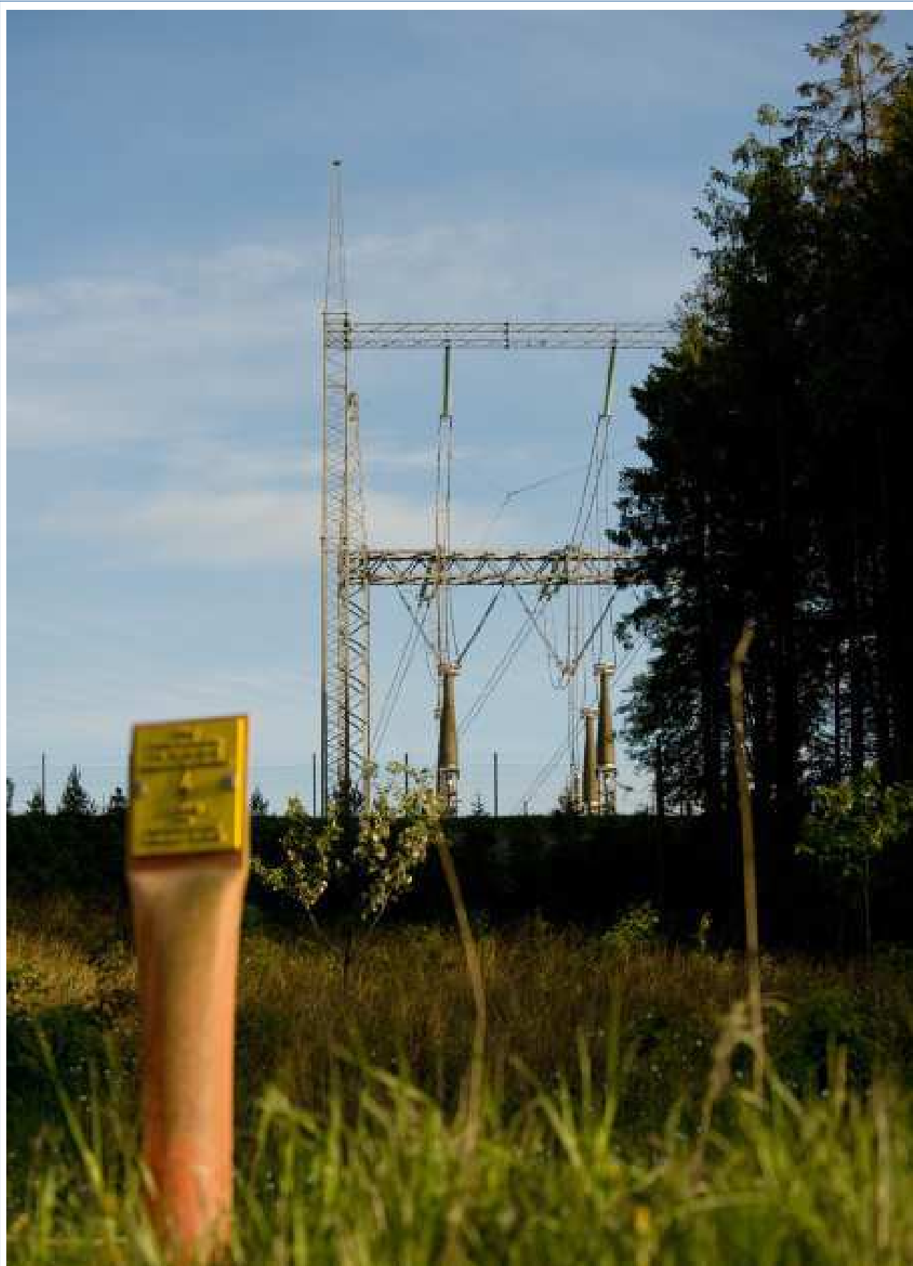
I en kabelstation føres ledningerne ned i jorden. En pæl markerer, hvor kablerne er nedgravet. Også ved jordkabler er der magnetfelter. Se eksempler i "Katalog over magnetfelternes størrelse ved forskellige anlægstyper".
