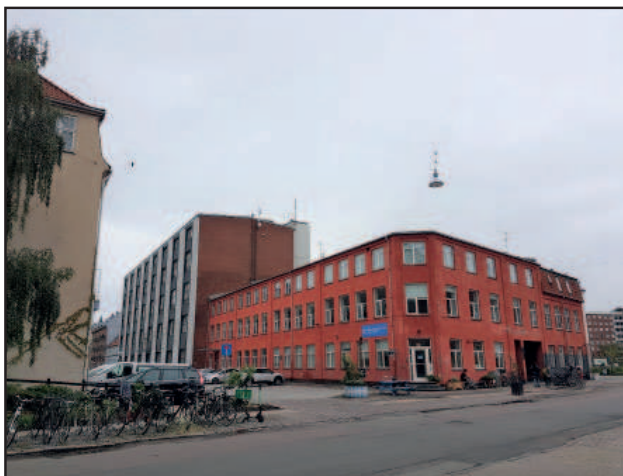
Billede af facaderække på Teglværksgade
