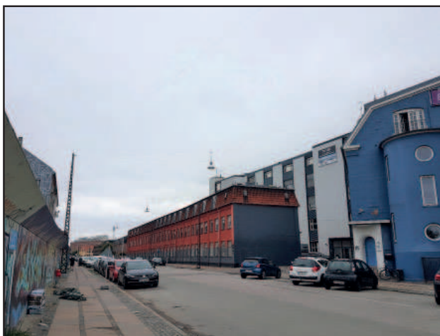
Eksisterende boligbebyggelse set fra Aldersrogade
