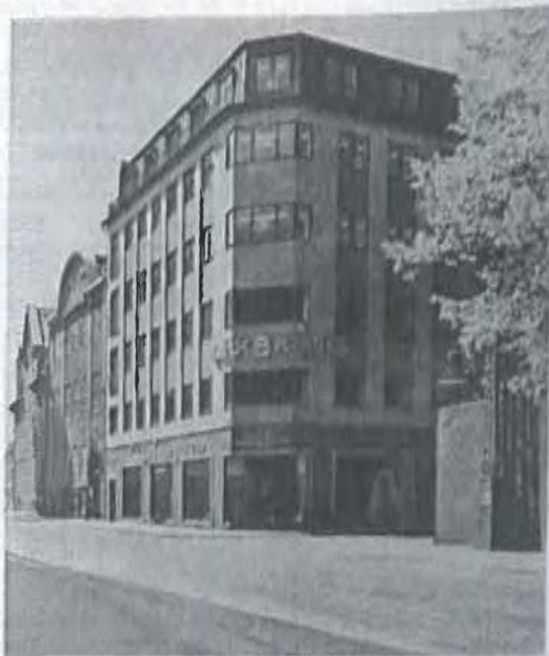
Sven Risom: Forretningsbygning paa Nørregade
