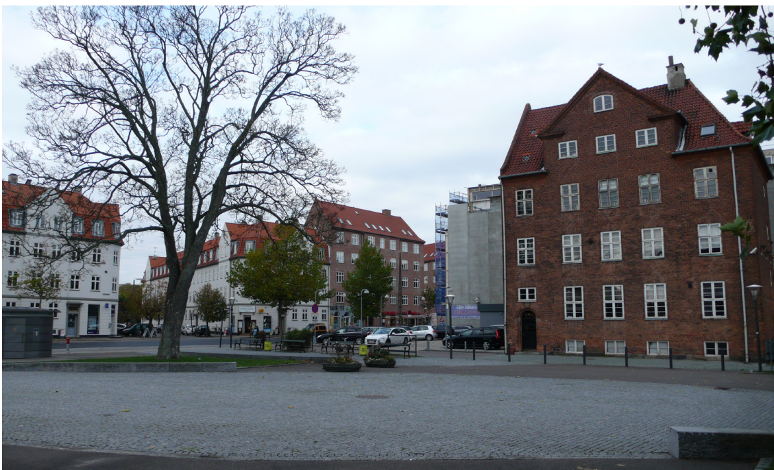
View med det bevaringsværdige murstenshus set i sammenhæng med Amagerbrogades øvrige bygninger og det store gamle lønnetræ.
