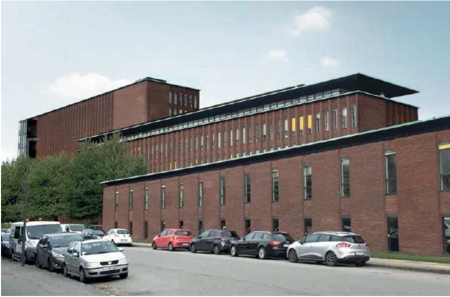
FLSmidth's hovedsæde set fra Ramsingsvej. De to højeste bygninger bevares. Den lave laboratoriebygning, forudsættes nedrevet og erstattet med boligbebyggelse i tre etager.
