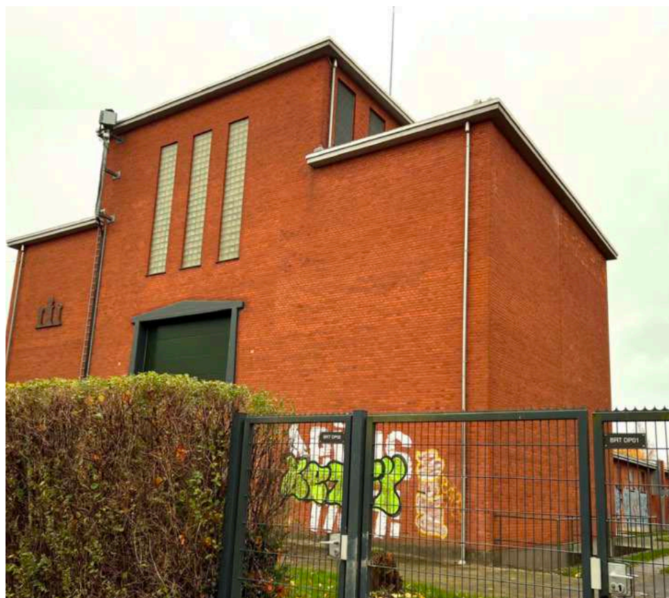
Transformestationen i Brønshøj blev opført i 1941 for at forsyne de store nye boligkvarterer i bydelen med strøm. Stationen er et typisk eksempel på Københavns Kommunes mange bygninger, der indgår i storbyens forsyning. Som del af et værdifuldt kulturmiljø, kommer bygningen og dens historie til sin ret som et vigtigt kulturspor, der vidner om Københavns historie og udviklingstræk.
