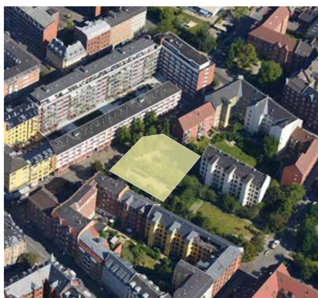
Skråfoto, Allersgade/Thorsgade set fra syd
