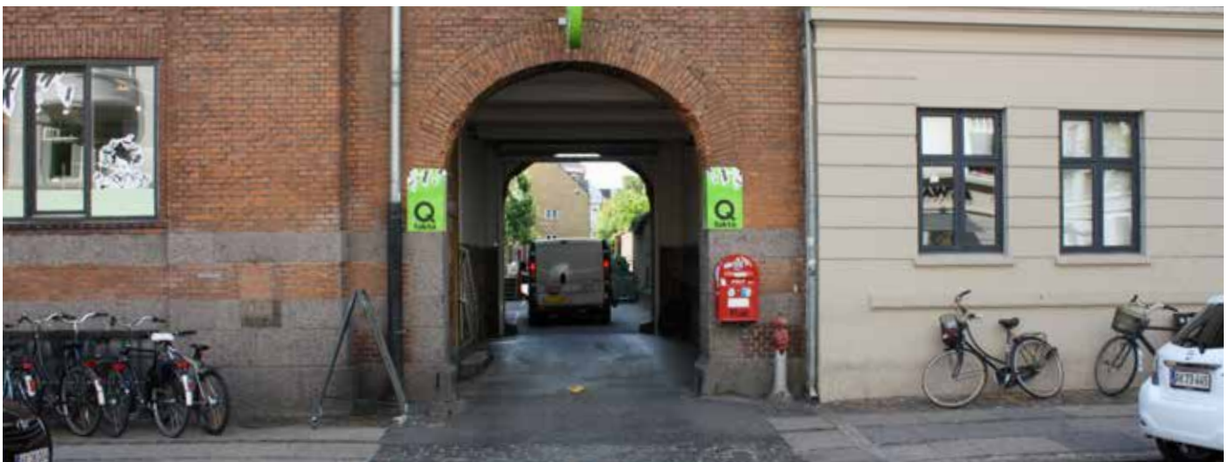
4: Indkørsel til øvre dæk af anlæg Viborggade via Århusgade
