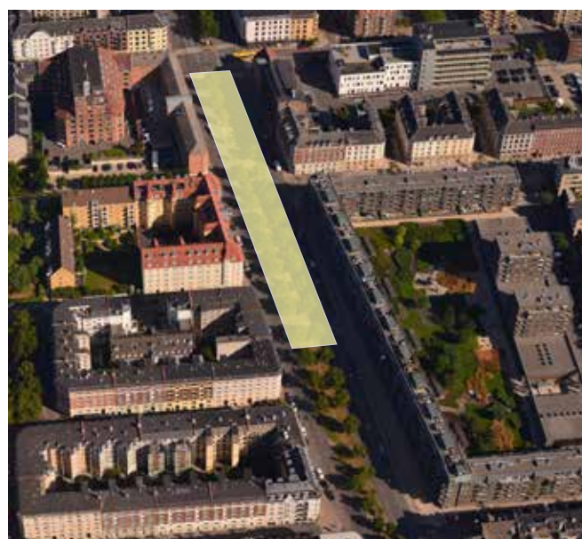
Skråfoto, Strandboulevarden set fra syd
