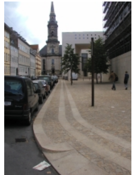
Fortovsbelægning langs Nørdeas hovedsæde i kinesisk gul sten med bred bordurkant og bodurganglinier.
