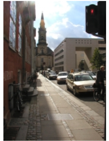
Traditionelt 'Christianshavner-fortov' af chaussesten, fortovsfliser og med bred bordurkant
