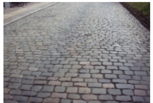
Brostensbelægning. Udføres med genanvendelse af eksisterende brosten efter fjernelse af asfalt (referencebilled).
