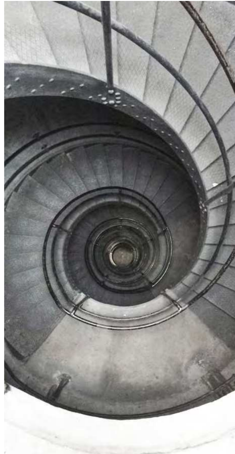
Trappe i vandtårnets centrum
