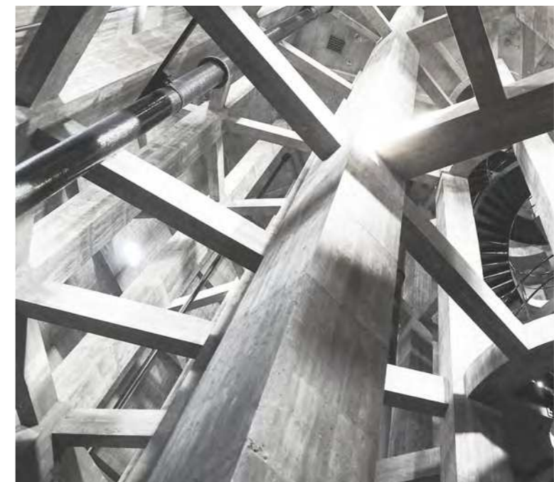
Søjlerummet som bærer den gamle vandtank
