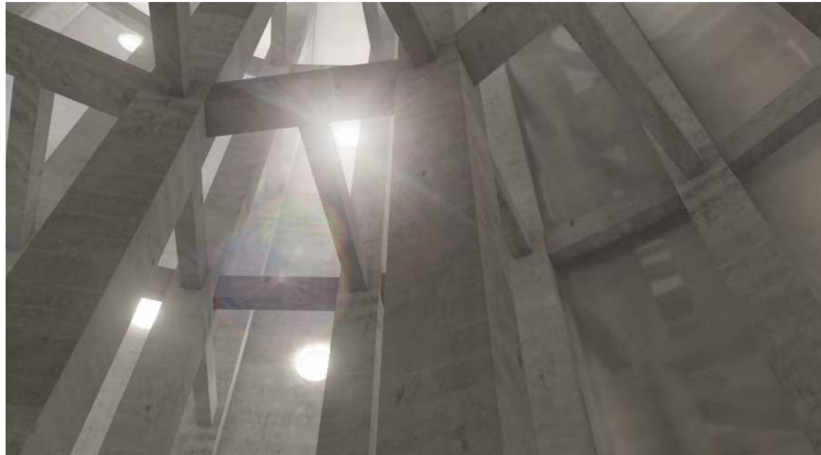
SØJLERUMMET/ Aluminiumsbeklædning på brandtrapperne
