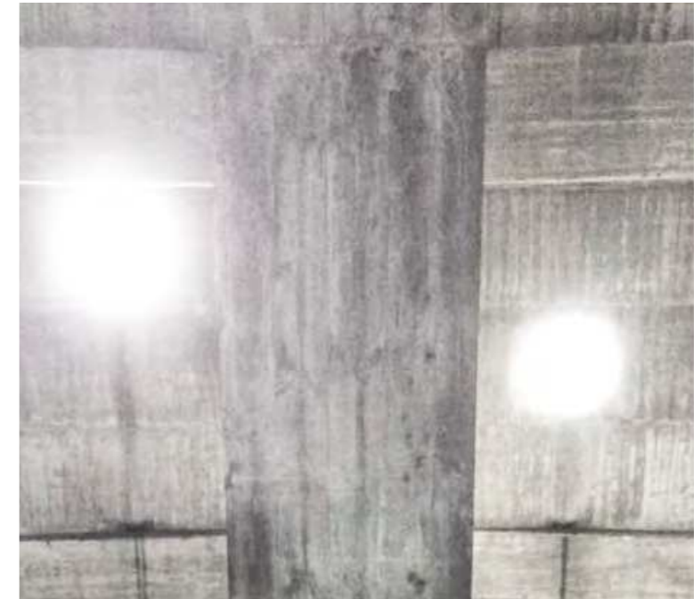
Vinduer i søjlerummet
