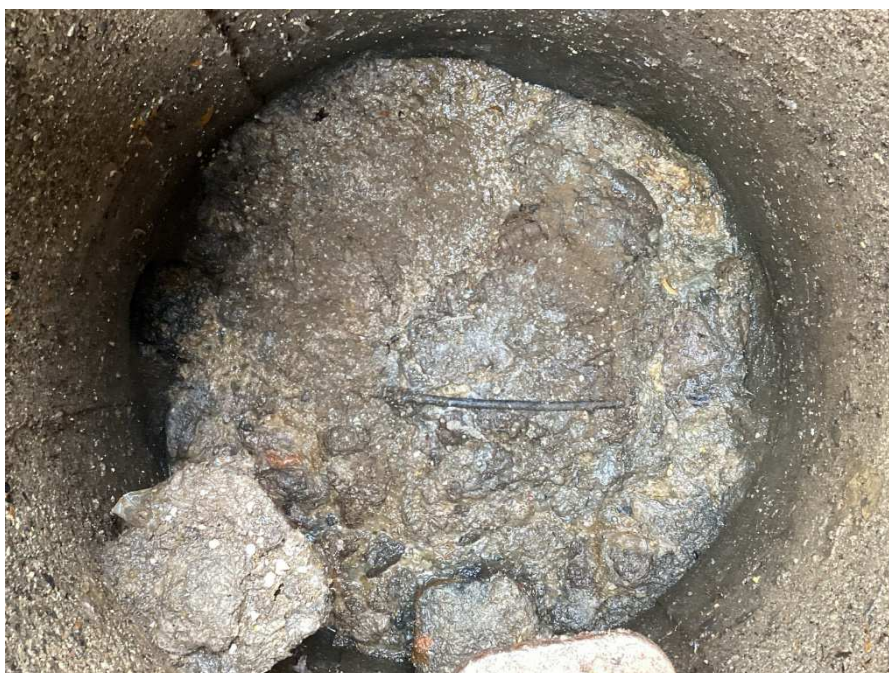
Billede 1. Kloak, som flyder over med afføring, da der ikke er gennemløb formentlig pga. brud
