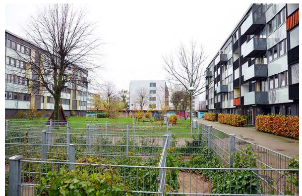
Remisevænget Øst til højre og tilhørende friarealer.
