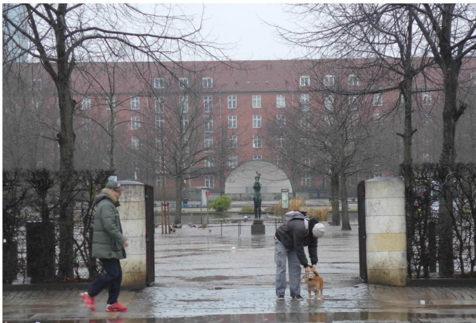
Hovedindgangen fra Enghavevej
