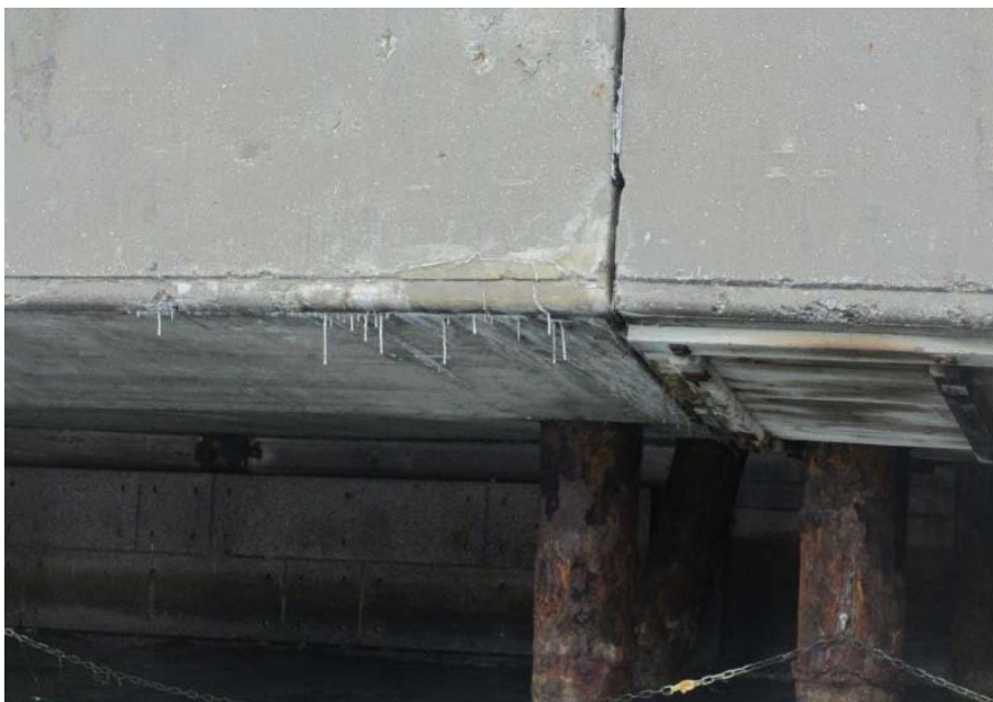
Revner i betonkonstruktioner med hvide udfældninger og drypsten
