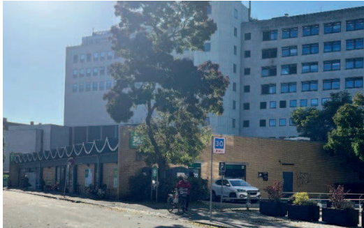
Eksisterende dagligvarebutik set fra nordvest, og indkørsel til Plejecenteret Aftensol.
