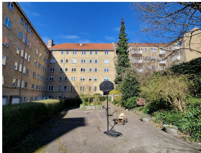
Eksisterende forhold Foto: Københavns Kommune
