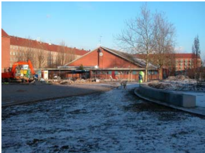
Sundbyøsterhallen ligger tilbagetrukket fra Amagerbrogade omgivet af boliger mod nord og Sundbyøster Skole og boliger mod syd. Mellem Amagerbrogade og hallen ligger Sundbyøster Plads, der i 2003 er omdannet til en tidssvarende plads.
