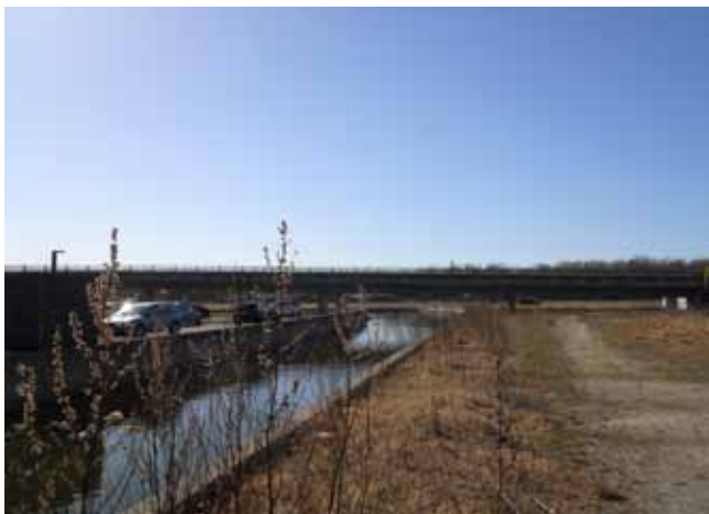
Byggegrunden støder mod syd op til den landskabelige kanal og mod vest til Metro.
