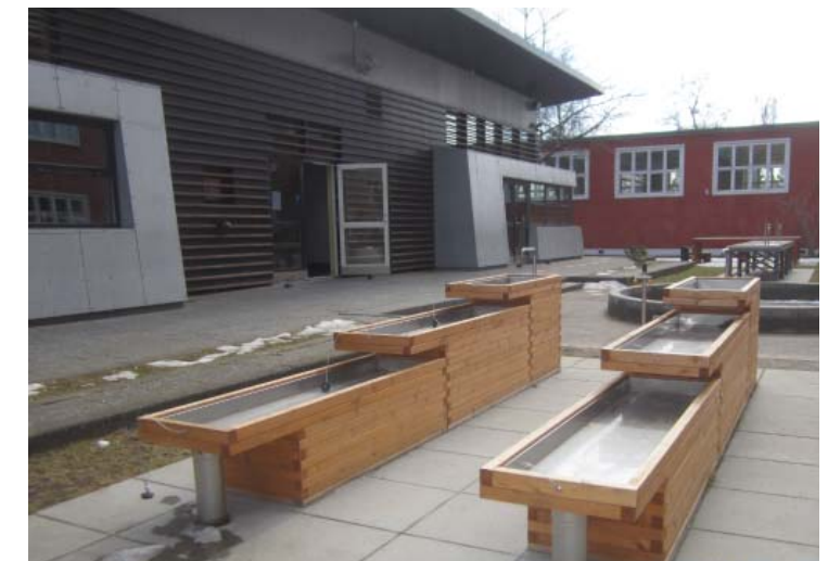
Bygningen øst for hovedbygningen
