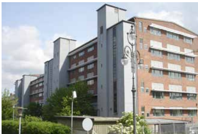
Ejendommen Tagensvej 135, set fra Superkilen. Byens Udvikling.
