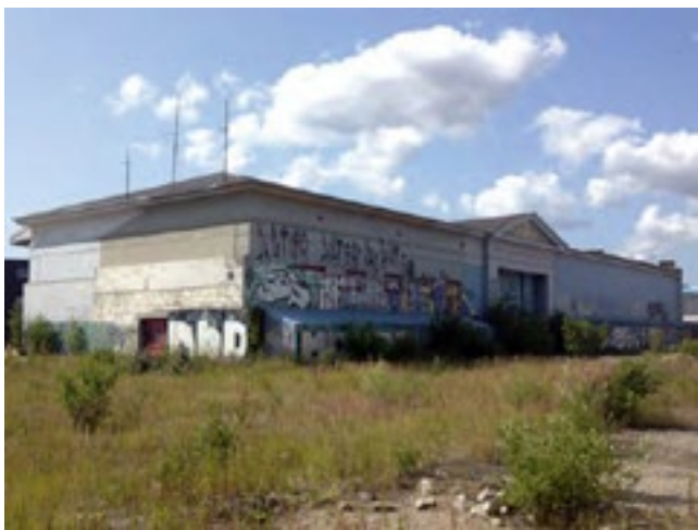
'Specialstålhallen' set fra Vasbygade. Foto: DesignGroup Architects
