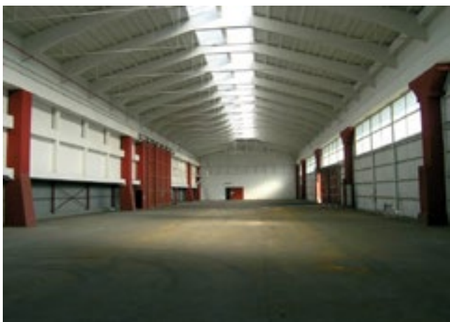
'Specialstålhallen' indvendig. Foto: DesignGroup Architects
