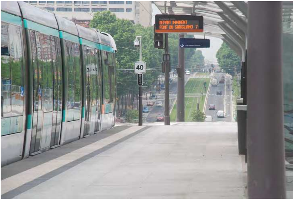
Paris. Letbanen fremstår på store dele af strækningen som et grønt tæppe, der mildner gadeprofilen og gør det langt mere behageligt både at opholde sig ved og cykle og gå langs med Boulevarden end det var tidligere.
