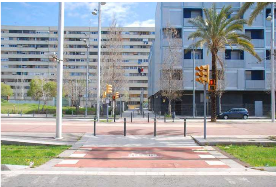
Barcelona, La Mina. Nyt boligbyggeri ved boulevarden, bagved ses det eksisterende
