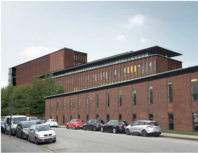
FLSmidth's hovedsæde set fra Ramsingsvej ved Vilhelm Thomsens Allé i dag. Forrest ses Laboratoriebygningen, som må fjernes, og bagved ses de to høje kontorfløje, i otte og fem etager, som skal bevares. Foto: COBE.
