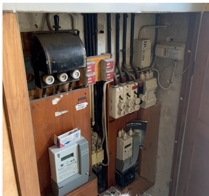
El-tavler udskiftes i alle lejligheder
