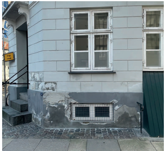
Fugtsikring af fundamenter og kælder
