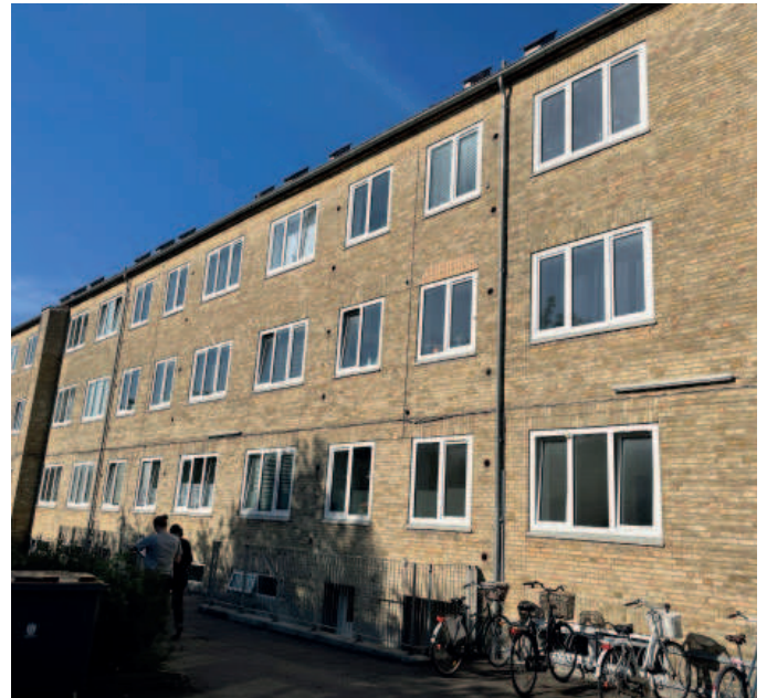
Udskiftning af vinduer til energioptimerede trævinduer
