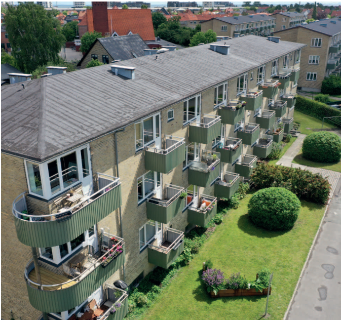
Tag udskiftes og efterisoleres
