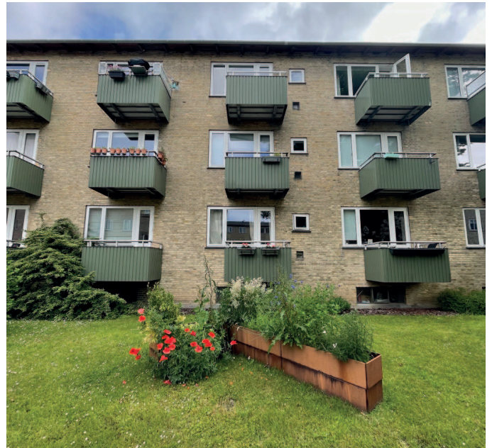
Ikke oprindelige vinduer udskiftes til trævinduer
