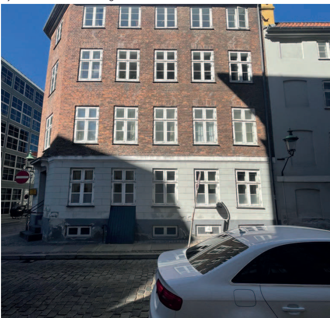
Ejendommen set fra gaden
