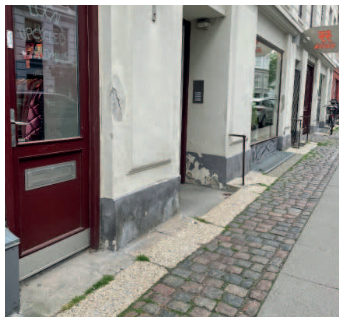
Ejendommen fugtsikres bl.a. ved etablering af omfangsdræn
