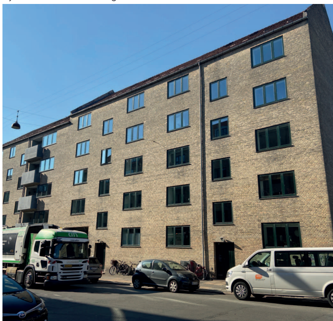
Ejendommen set fra gaden
