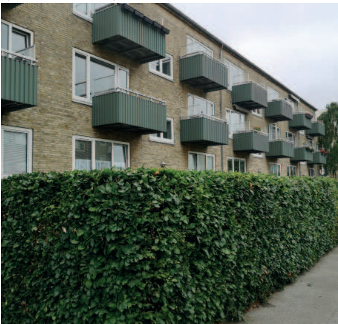
Ejendommen set fra gaden
