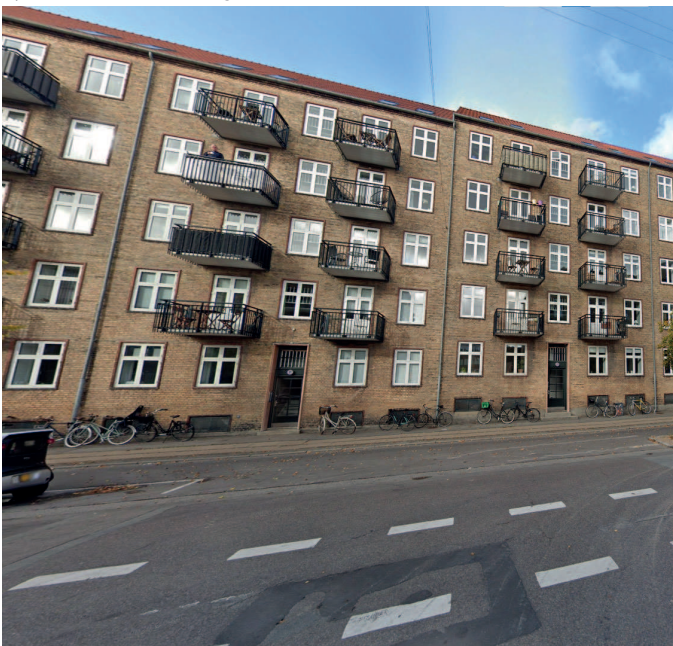
Ejendommen set fra gaden
