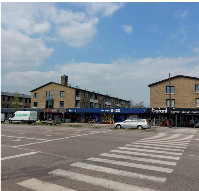
Ejendommen set fra gaden
