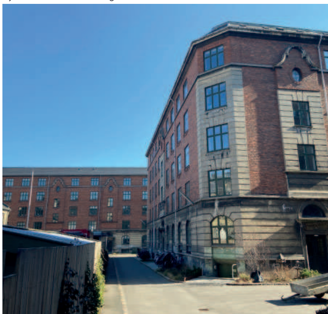
Ejendommen set fra gaden
