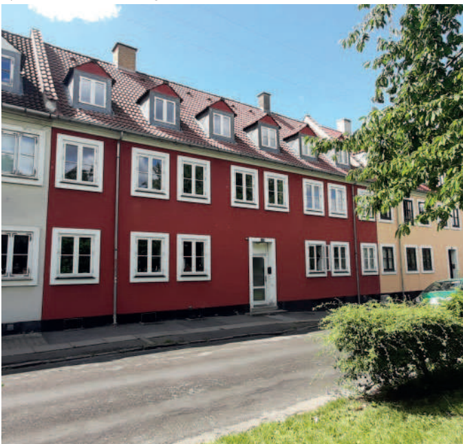
Ejendommen set fra gaden
