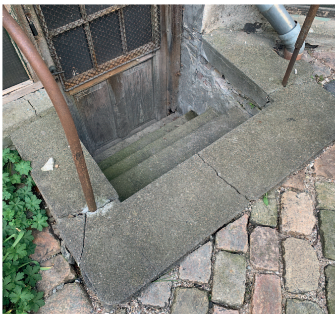
Kældertrapper og lyskasser skybrudssikres
