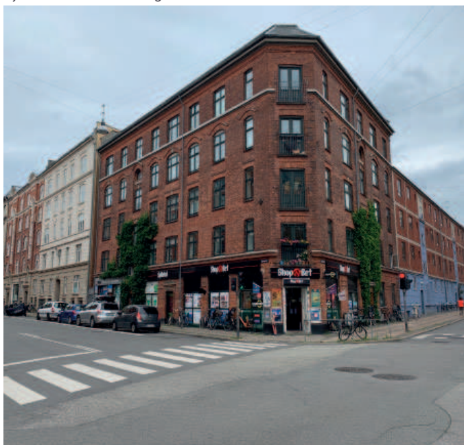
Ejendommen set fra gaden
