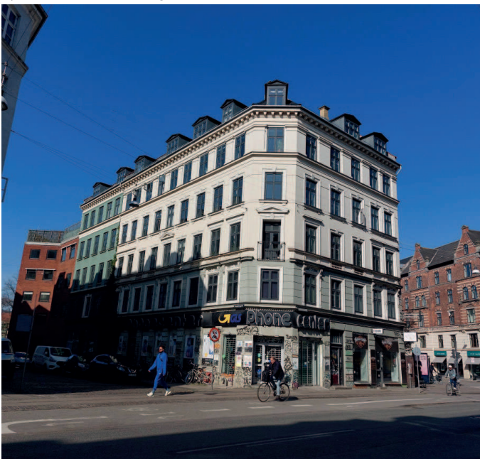
Ejendommen set fra gaden
