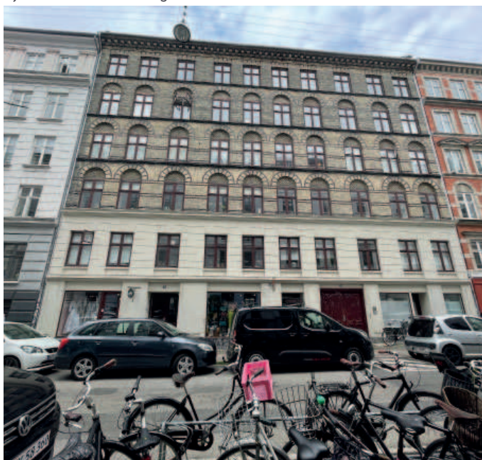
Ejendommen set fra gaden
