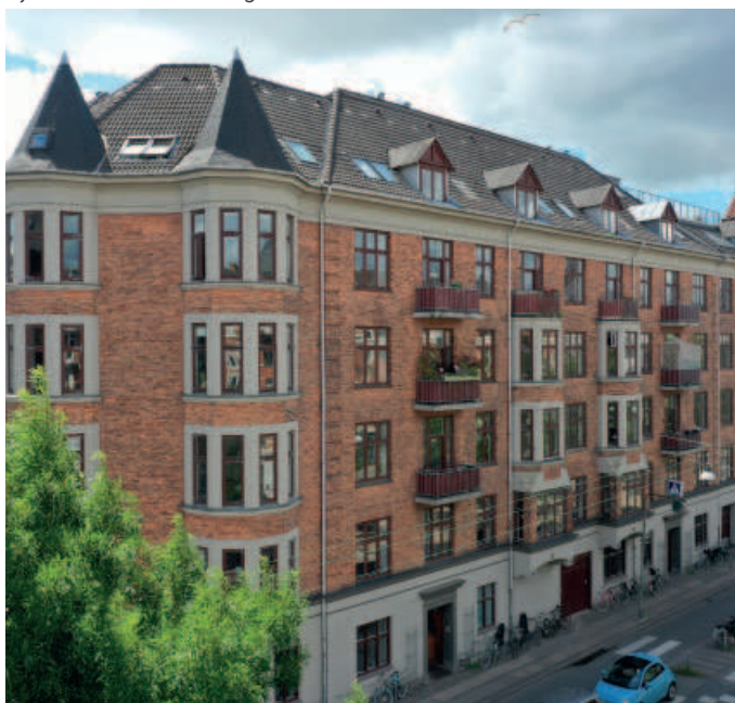
Ejendommen set fra gaden
