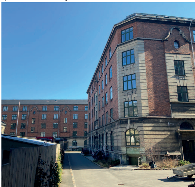
Ejendommen set fra gaden
