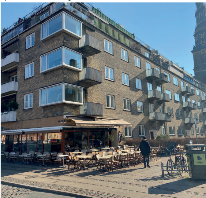
Ejendommen set fra gaden
