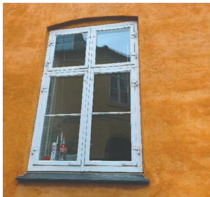
Der etableres forsatsrudder på oprindelige vinduer
