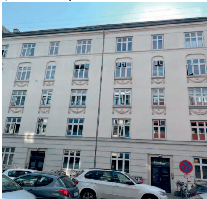
Ejendommen set fra gaden
