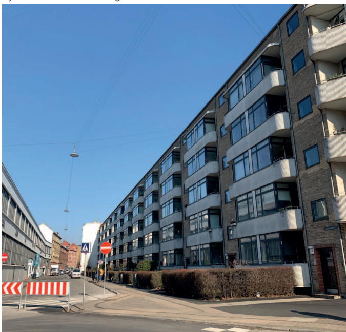
Ejendommen set fra gaden
