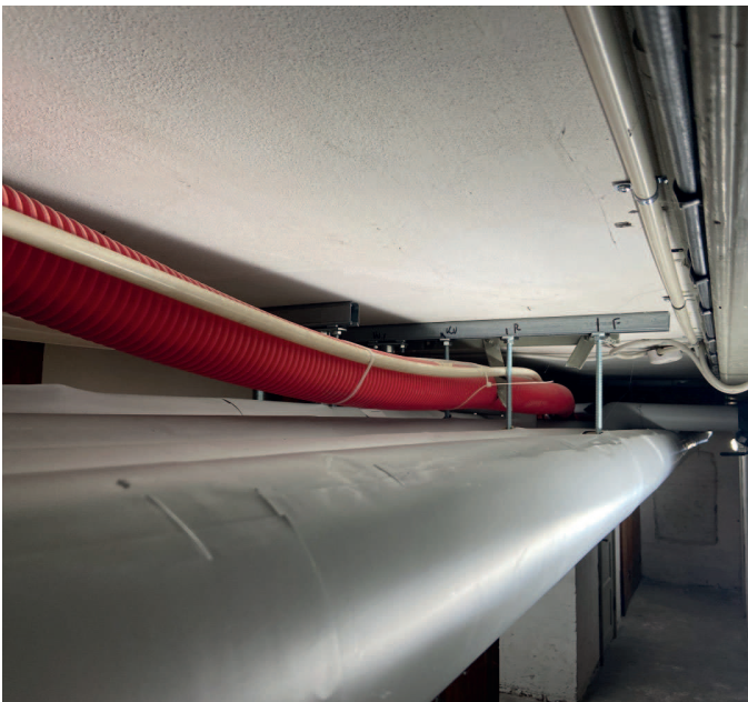
Der efterisoleres mod kælder
