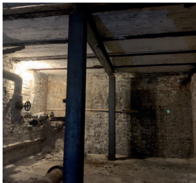
Dæk over portgennemgang sikres ift. korrosion
