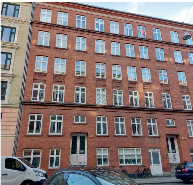
Ejendommen set fra gaden
