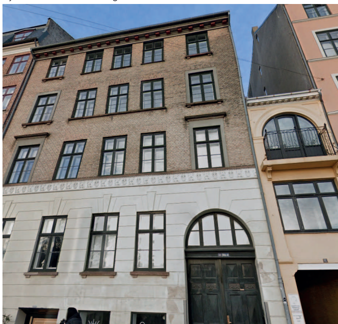
Ejendommen set fra gaden
