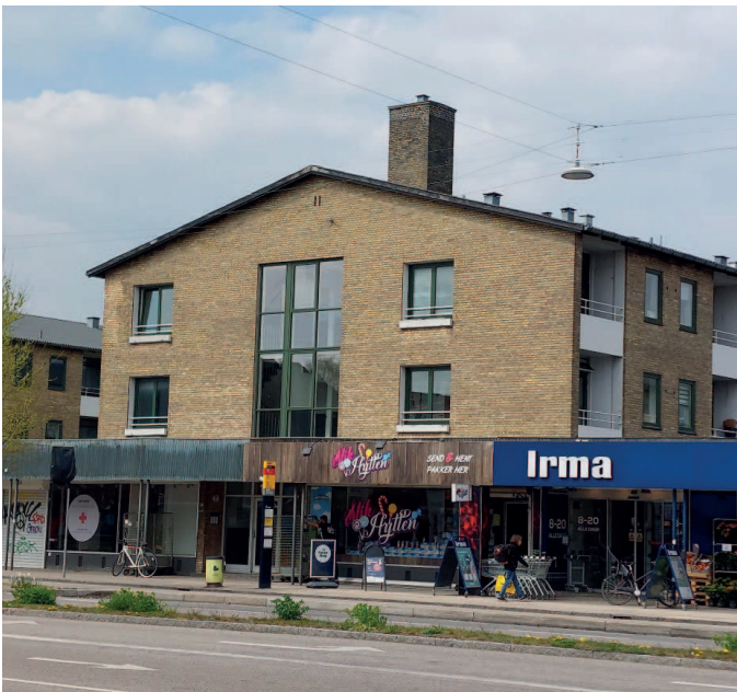
Gadefacade mod Roskildevej
