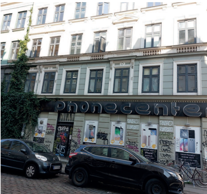
Gadefacade fra Skodsborggade
