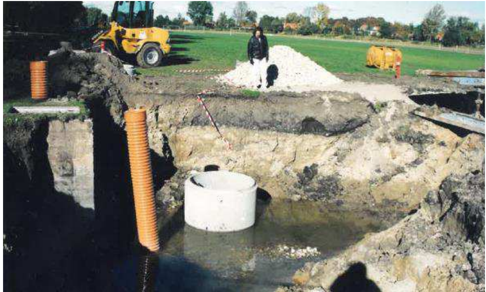
Figur 2.16: Foto fra anlæggelse af drænet I 2004. Den firkantede betonbrønd til venstre i billedet er kloakken, mens den runde betonring er den nuværende brønd med højvandslukke i bunden. Foto fremsendt af Københavns Kommune, Boris Koppel.
