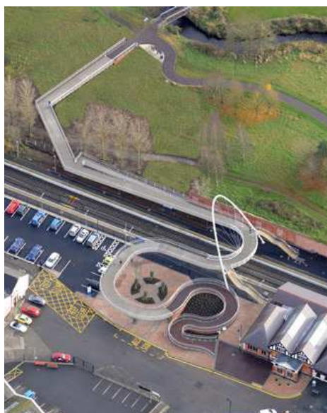
Eksempel på gangbro med de nødvendige ramper over en jernbane, Bally Money Train Station, Nordirland
