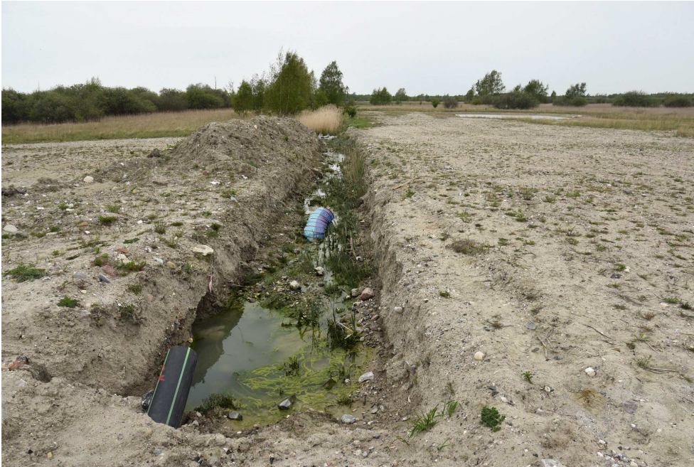
Figur 2 - Opfyldning ud for skolen i den sydlige del af området – Maj 2017. Grænsen mellem den påfyldte jord og den gamle overflade ses tydeligt i den gennemgravede grøft.
