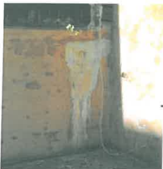
1. Fugtneudsivning fra hævet terrænniveau
