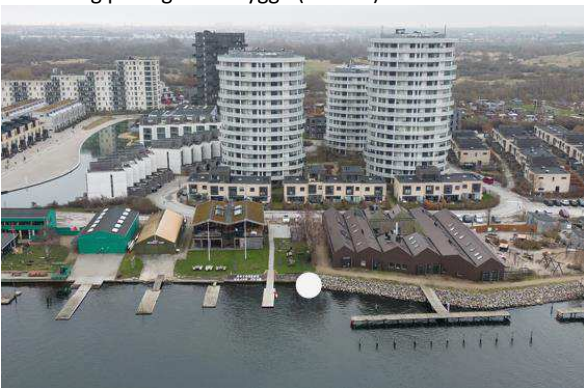
Tilslutning på Islands Brygge (Punkt 9)
